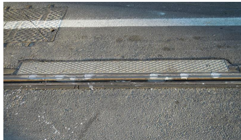
Erogatore di fluido correttore di attrito. Sopprime lo stridio in curva. Si utilizzano anche soluzioni con erogatore del fluido a bordo del veicolo, anziché a terra
