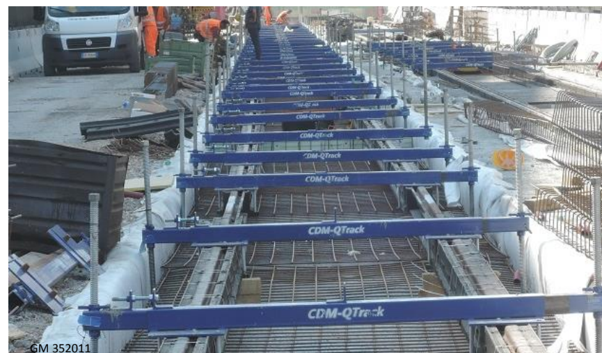
«Embedded Rail System» (Firenze, via di Novoli: realizzazione della linea T2, fase di allineamento delle rotaie (2015)
